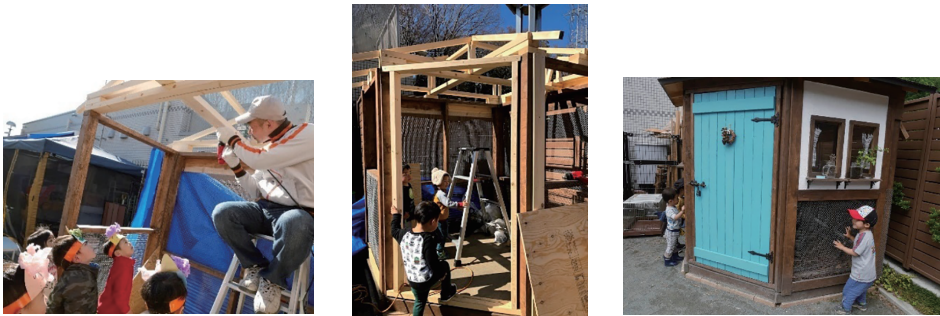
図2 小屋建築の様子
